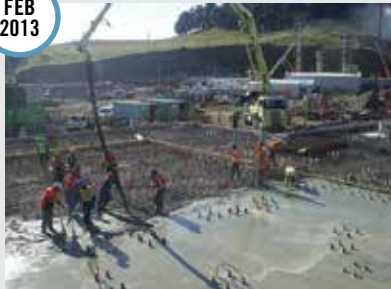
Concrete pour of main foundation slab
